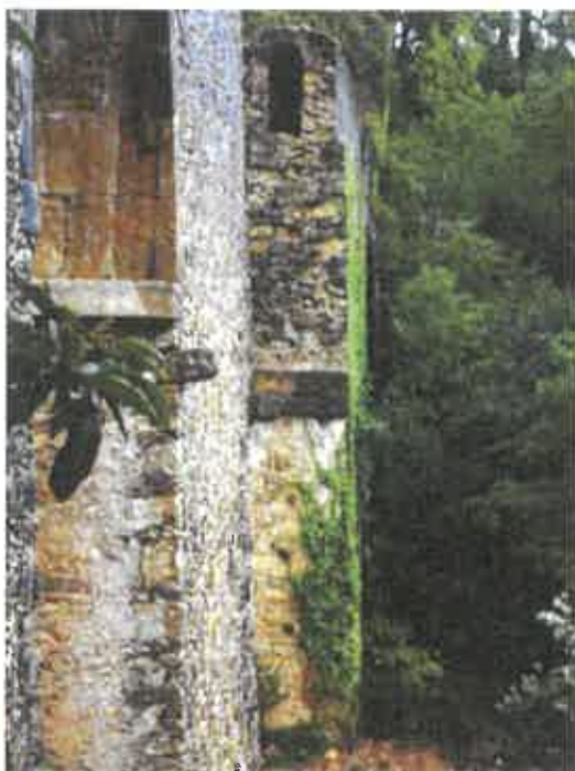
Imagem 42 -- Foto da zona das arcarias junto à estrada da mina com corte. 96
