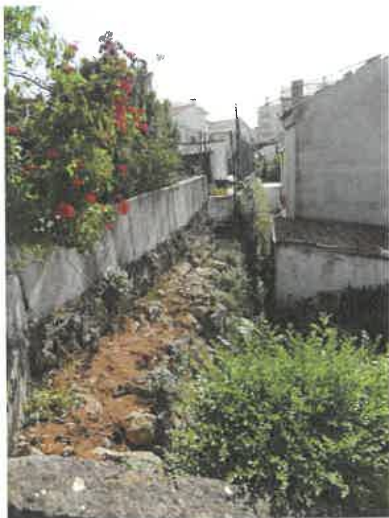
Imagem 80 – Foto do aqueduto a passar por baixo das habitações. 128
