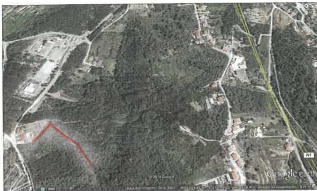
Imagem 29 – O aqueduto prolonga-se em direcção à antiga Estrada da Mina com troços, tanto ao nível do solo como sobre ele, surgindo em arcarias de arcos de volta perfeita, consoante a necessidade de nívelação.
