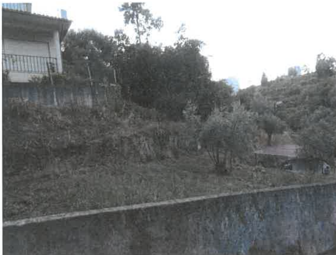
Imagem 61 - Foto do aqueduto após passar por baixo da estrada da Rua Mário Pio, aparecendo a sair de baixo das habitações. 114
