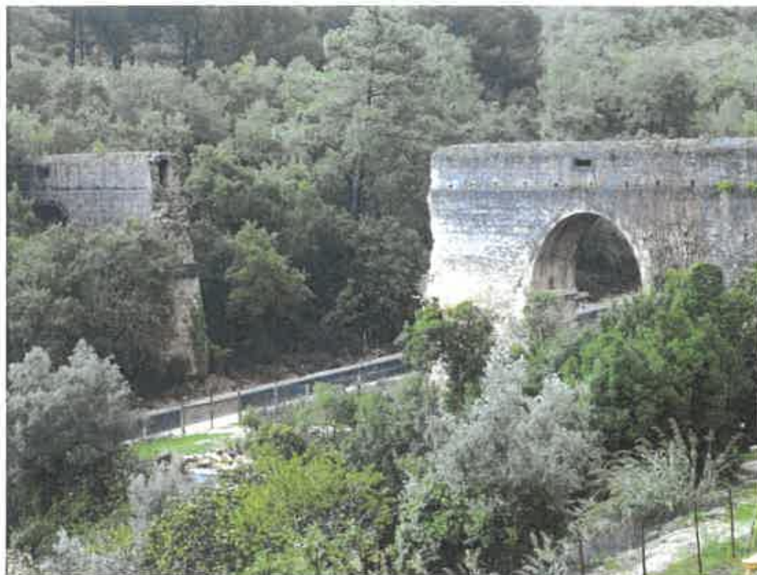
Imagem 43 – Foto da zona do corte das arcarias com a passagem da estrada da mina a meio. 97
