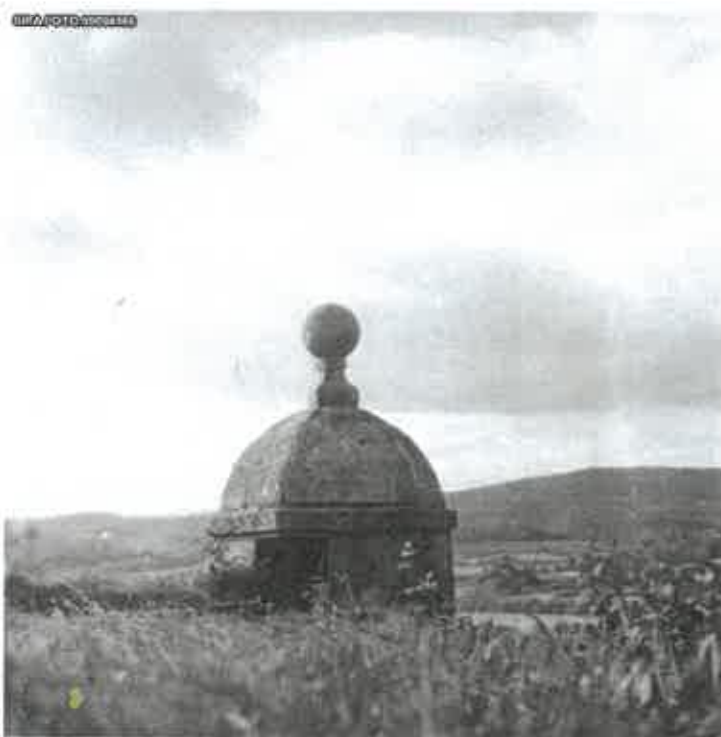
Imagem 22 - Construção cilíndrica rematada de uma cobertura cónica que protege a nascente da Granja do aqueduto de Santa Clara. 81
