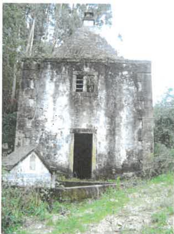
Imagem 24 – Mãe de água do aqueduto de Santa Clara, de estrutura paralelepipedal com remate piramidal. 82
