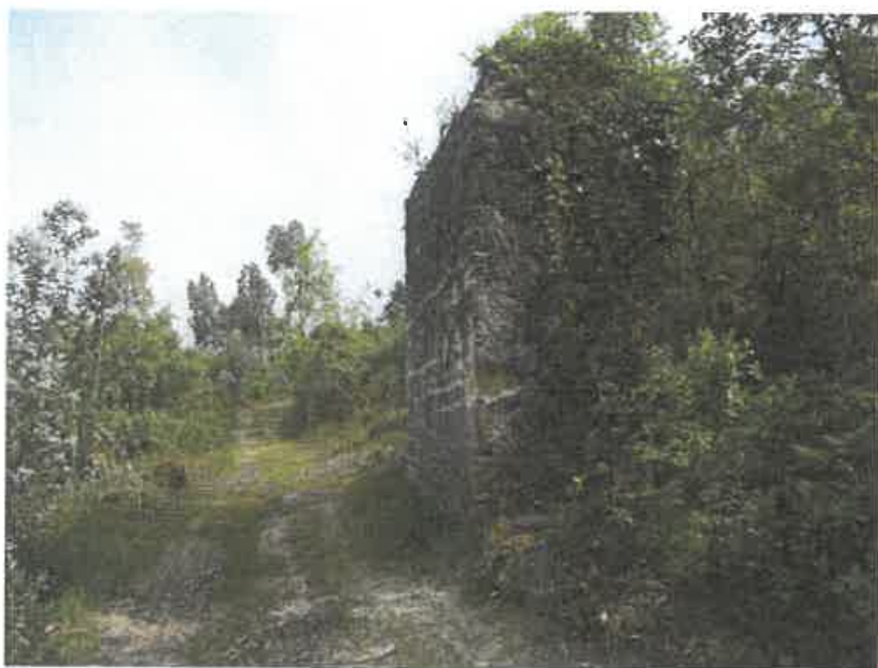
Imagem 28 – Respiradouros (caixas de luz e ar) junto da mãe de água, no prolongamento do percurso do aqueduto. 85
