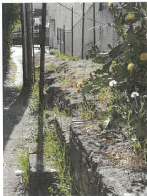
Imagem 81 – Foto do aqueduto antes da intercepção com a estrada da Rua dos Milagres das Rosas. 129
