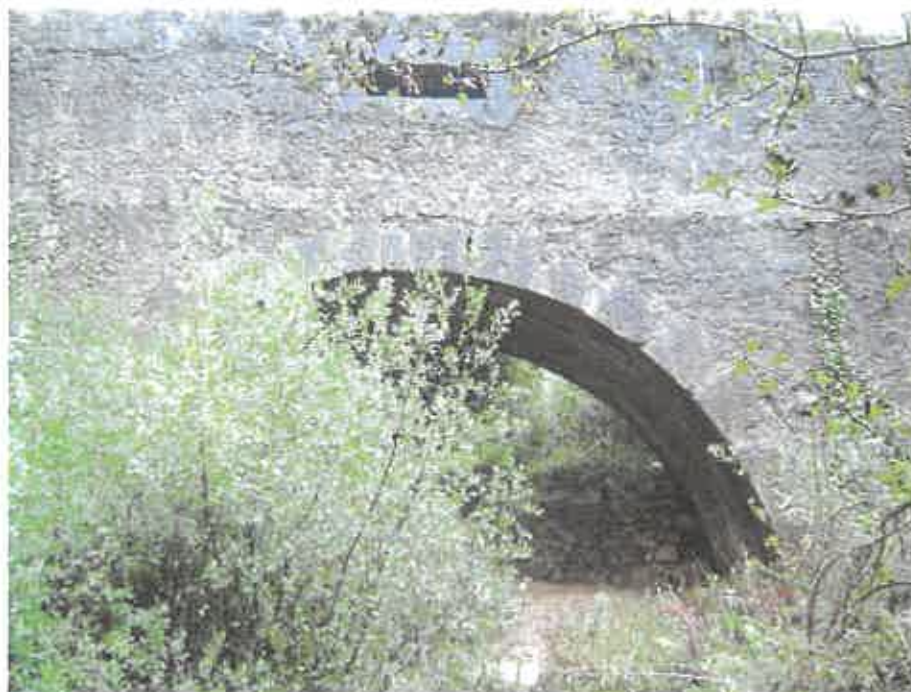
Imagem 47 – Foto do último arco visível antes do aqueduto terminar. 101
