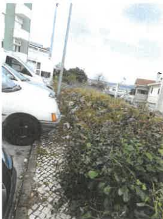
Imagem 91 – Foto do prolongamento do aqueduto depois da intercepção com a Rua Rui Braga Carrington da Costa e indo em direcção ao mosteiro. 138
