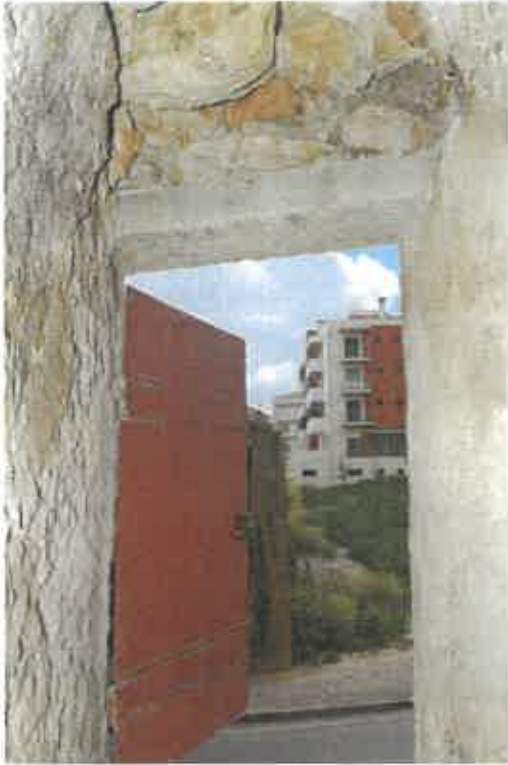
Imagem 90 – Foto do interior do aqueduto para o exterior na zona do corte. 137
