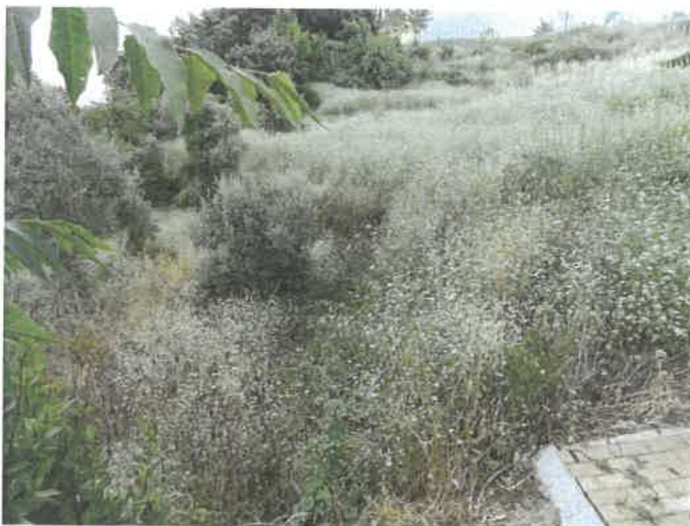
Imagem 69 – Foto do aqueduto visto da Rua da Volta das Calçadas. 119
