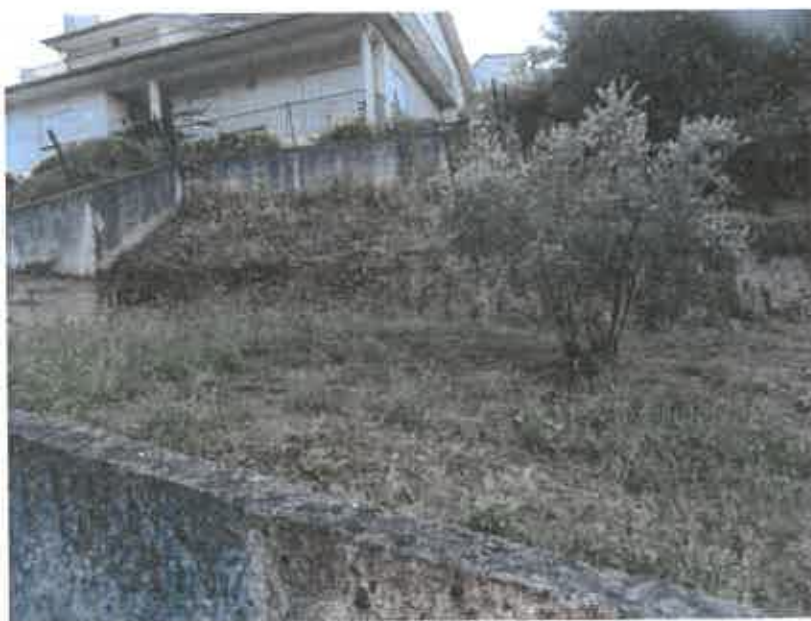
Imagem 60 – Foto do aqueduto após passar por baixo da estrada da Rua Mário Pio, aparecendo a sair de baixo das habitações. 113
