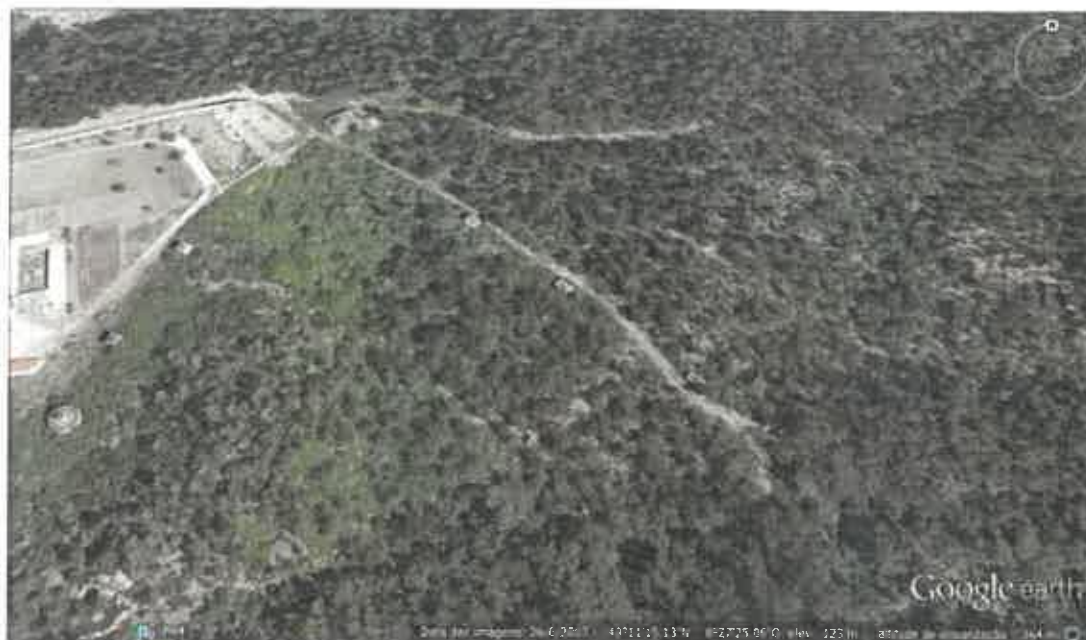
Imagem 21 – Imagem do Google Earth onde se vê o início do aqueduto de Santa Clara. Tem o seu início na nascente da Granja, em Santa Clara, sob uma construção cilíndrica rematada de uma cobertura cónica.
