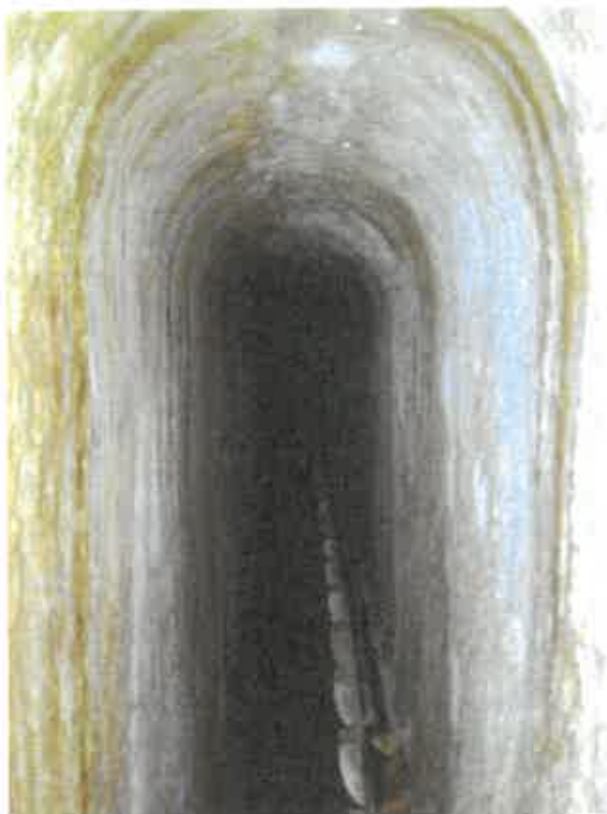
Imagem 33 – Por questões de nívelação, em alguns troços a água é encaminhada por mísulas de cantaria. 89
