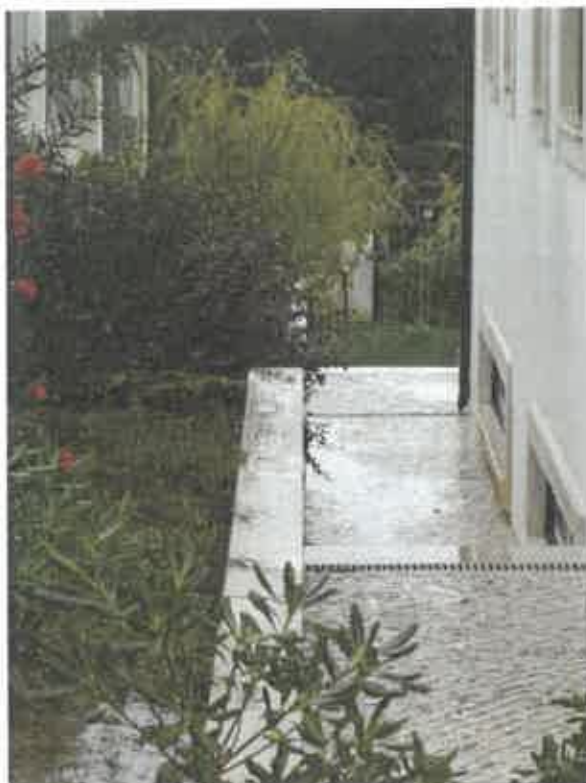
Imagem 39 – Ao fundo, o respiradouro que se encontra dentro de um quintal de uma habitação. 94
