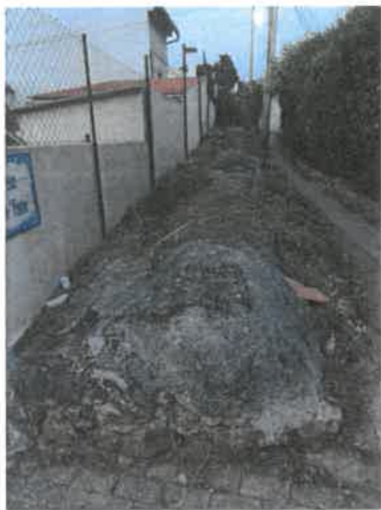
Imagem 82 - Foto do aqueduto antes da intercepção com a estrada da Rua dos Milagres das Rosas. 130
