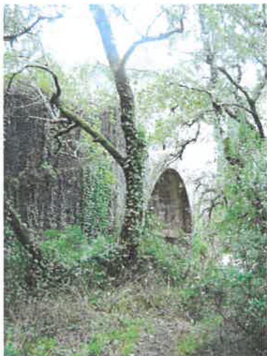
Imagem 45 – foto da zona este das arcarias junto à estrada da mina. 99
