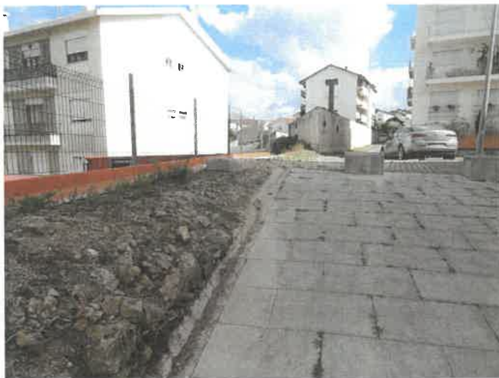
Imagem 84 - Foto das habitações que se colaram ao aqueduto no troço a seguir à intercepção com a estrada da Rua Milagres das Rosas. 132
