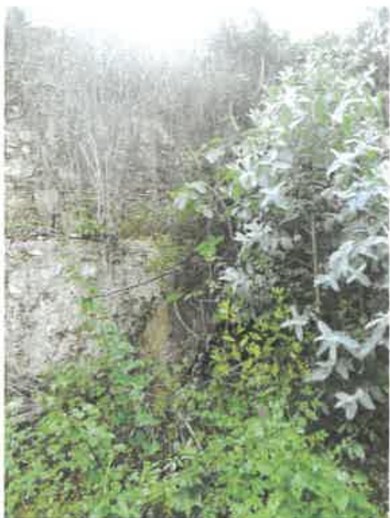
Imagem 31 - Nível que emerge do solo em arcarias de arcos de volta perfeita. 87
