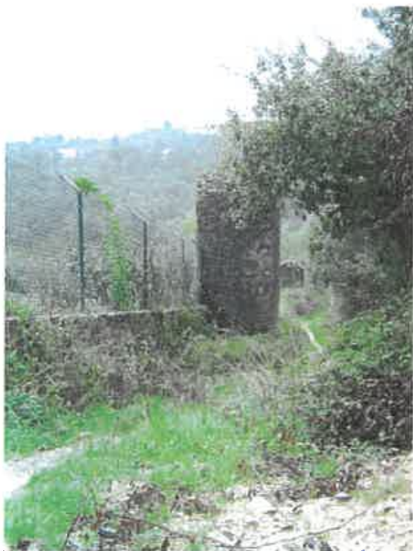
Imagem 41 – Lanço do aqueduto antes da arcaria junto à estrada da mina, em que os respiradouros foram aproveitados para limite da cerca de uma quinta privada. 95
