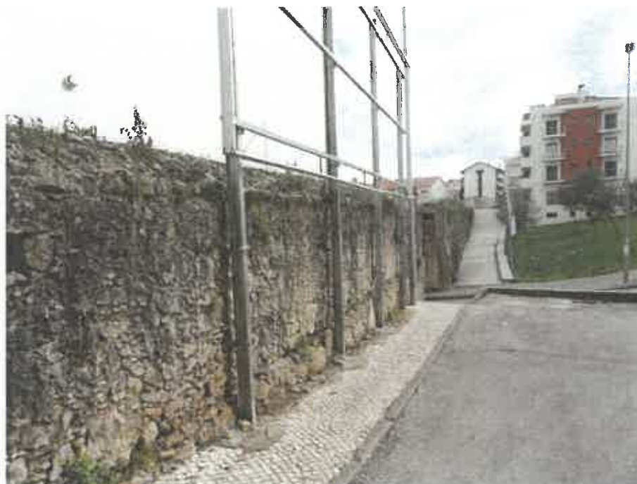
Imagem 88 - Foto do aqueduto junto à Rua Rui Braga Carrington da Costa. 135
