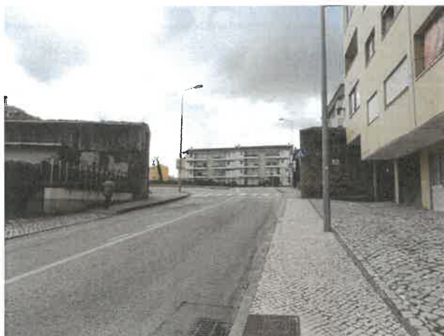
Imagem 89 - Foto do corte no aqueduto com a Rua Rui Braga Carrington da Costa. 136
